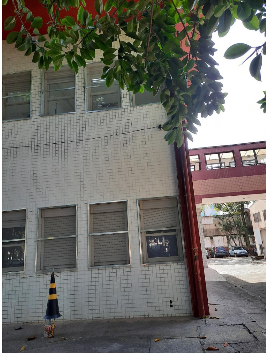
Figura 5 – Vista do pilar de canto
