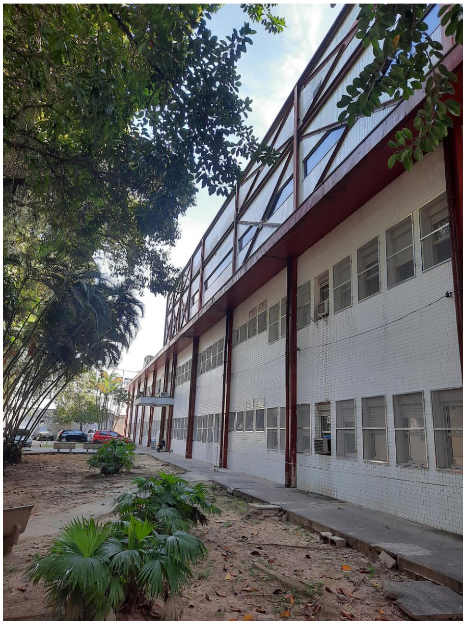
Figura 4 – Vista lateral do edifício
