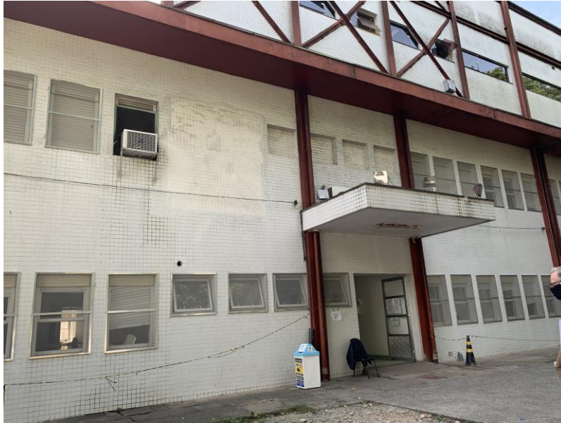
Figura 2 – Fachada do prédio vistoriado
