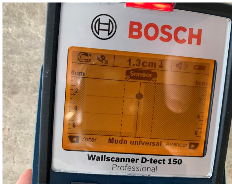
Figura 3 – Investigação da armadura da estrutura com equipamento scanner D-tect 150 Bosch
