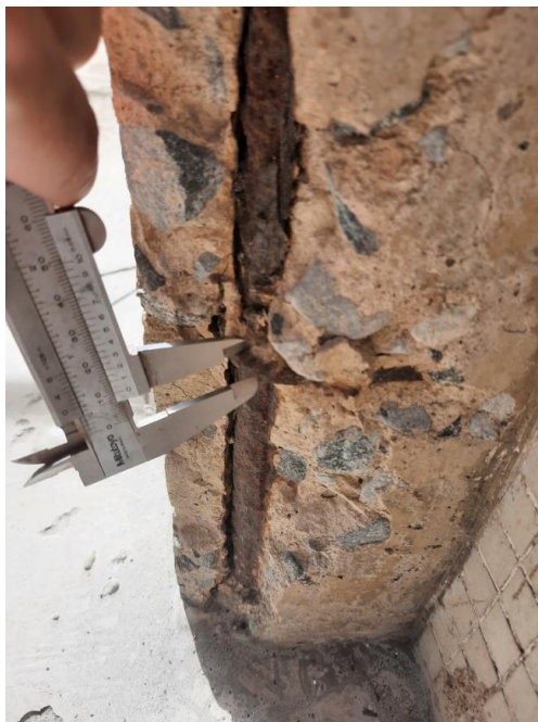
Figura 20 – Verificação da armadura em pilar com armadura exposta
