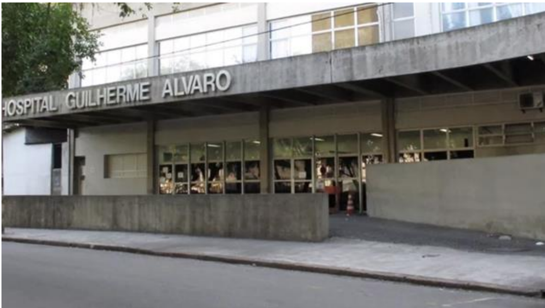
Figura 30 – Vista geral da marquise do prédio vistoriado
