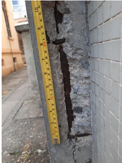
Figura 24 – Verificação da armadura em pilar com armadura exposta
