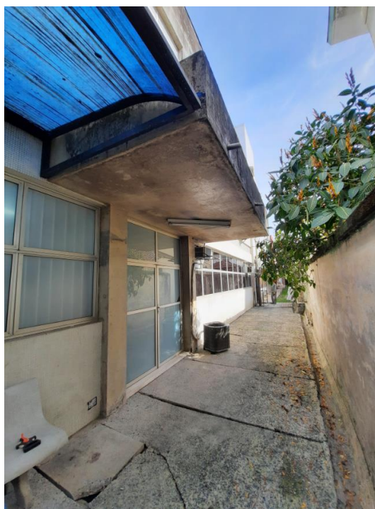
Figura 17 – Vista da fachada lateral do prédio vistoriado
