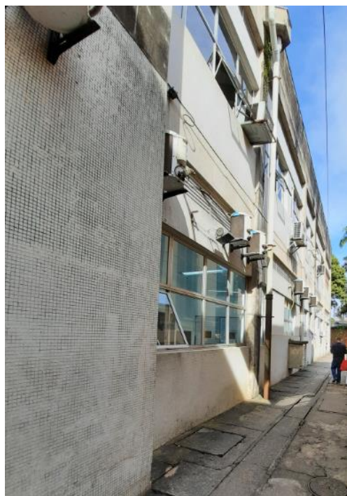
Figura 21 – Vista da fachada lateral do prédio vistoriado
