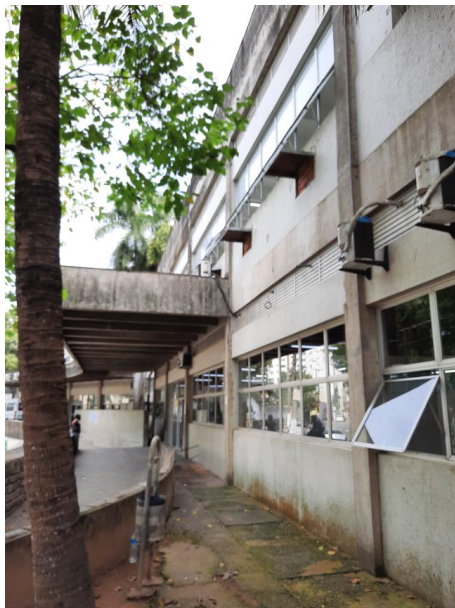
Figura 31 – Vista lateral da marquise do prédio vistoriado
