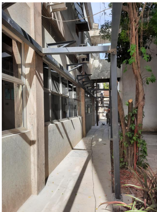
Figura 11 – Vista de uma das laterais do prédio vistoriado
