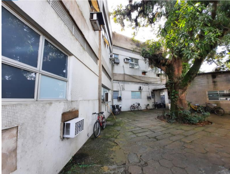
Figura 26 – Vista de uma das laterais do prédio vistoriado
