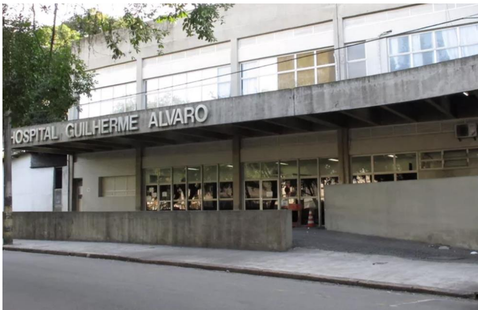
Figura 2 – Fachada do prédio vistoriado
