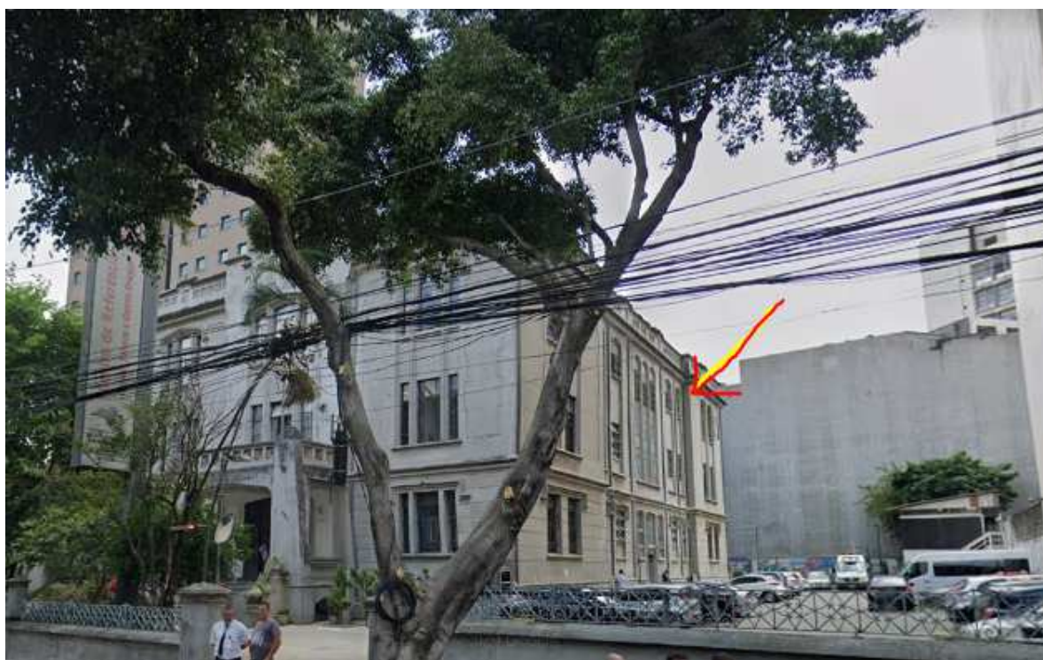
Figura 6 – REGIÃO PROPOSTA PARA CONSTRUÇÃO DA NOVA ESCADA METÁLICA – Imagem extraída do google Maps
